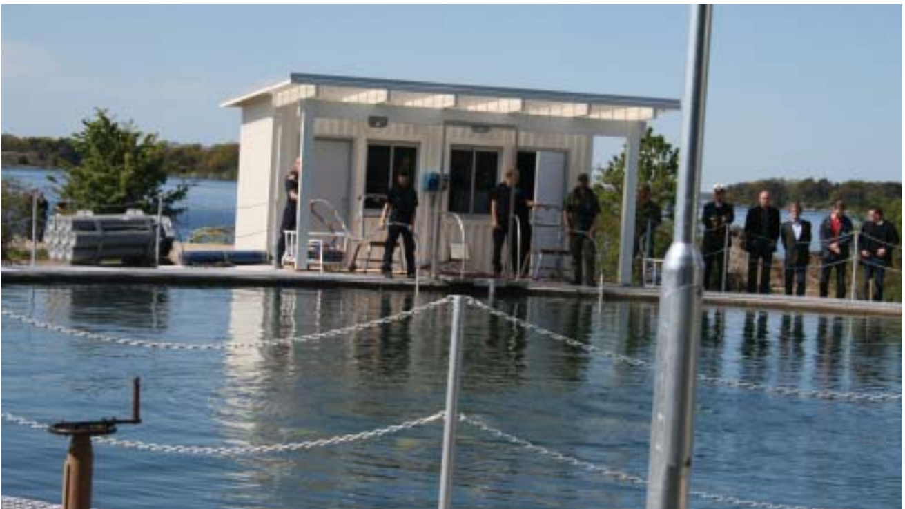
Den nya övningsanläggningen är bl.a. byggd i en av reningsverkets gamla bassänger
