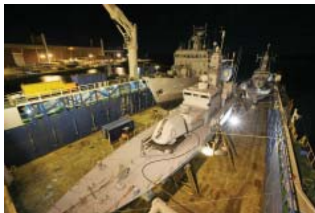
Arbetet med att svetsa fast stöttor och annat pågick dygnet runt under flera dagar Foto Ingmar Elofsson
