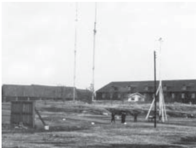
Stationen på Lindholmen. Observera Inventarietnummer 2. Fyrkanten och bakom denna byggnad Wasaskjul
